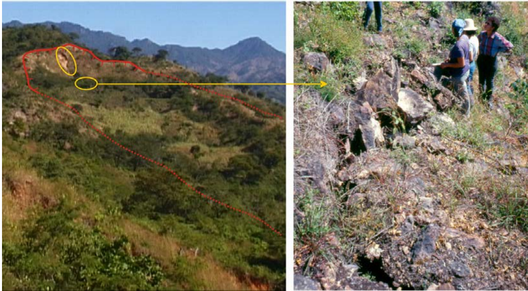
Fig. 1.8. Ejemplo de una antigua colada de tierra identificada en la zona del municipio de Cinco Pinos (límites de movimiento en rojo), con indicios de removilización (a la Izquierda). A la derecha, detalle de apertura de grietas en el terreno.
