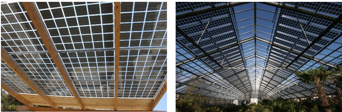
Fig 1. Imagen de ejemplos de módulos fotovoltaicos semi-transparentes para aplicaciones de BIPV y Agrovoltaica basados en la integración de células de Si cristalino.
