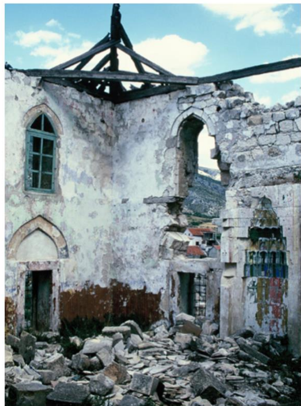
Ilustración 4. El interior de la Mezquita Sevri Hadzi antes de su reconstrucción Fuente: ICOMOS
