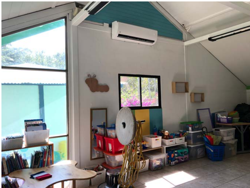
Imagen 25: Ventanas y aire acondicionado
