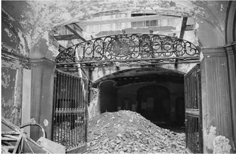
Figura 7. Moment de l'enderroc del forjat del pati (fotografia de Montserrat Segarra, 1982). Font: Arxiu del Departament de Cultura de la Generalitat de Catalunya.
