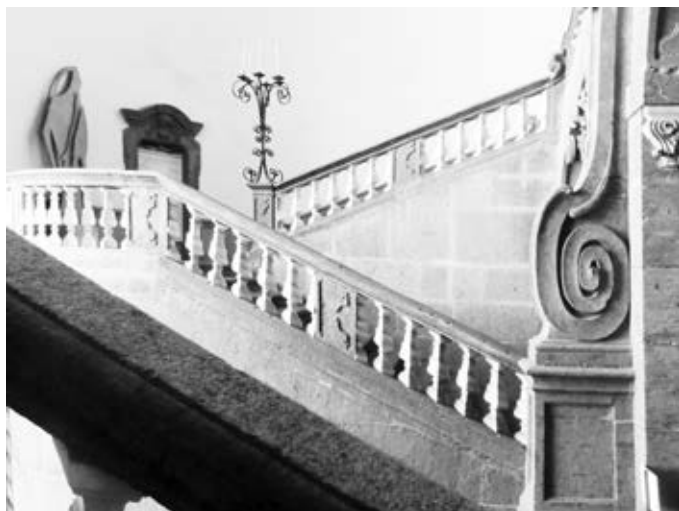
Figura 4. Napoli, Palazzo Serra di Cassano. Particolare della scala (foto dell'autrice).
