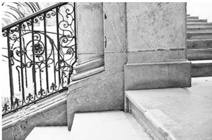
Figura 6. Barana amb motius decoratius de ferro i obliquïtat de la columna al Palau Palmerola (fotografia de Conxi Duro).
