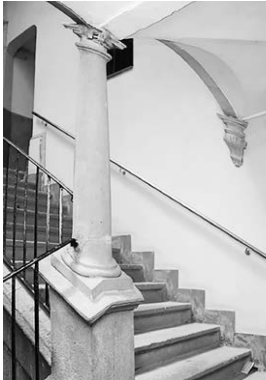
Figura 8. Base semiobliqua i projecció del capitell en la paret amb motius decoratius a la casa del carrer de la Blanqueria número 13 (fotografia de Conxi Duro).
