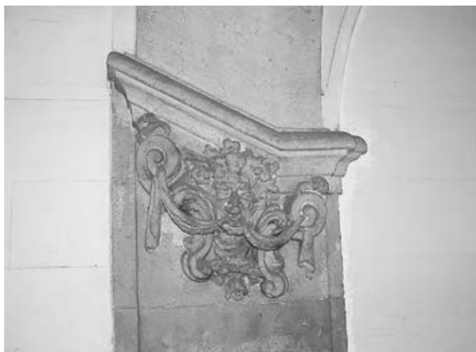
Figura 7. Capitell ornamental de forma semiobliqua de la pilastra projectada en la paret a la casa Martí Fàbregas del carrer de la Portaferissa (fotografia de Conxi Duro).
