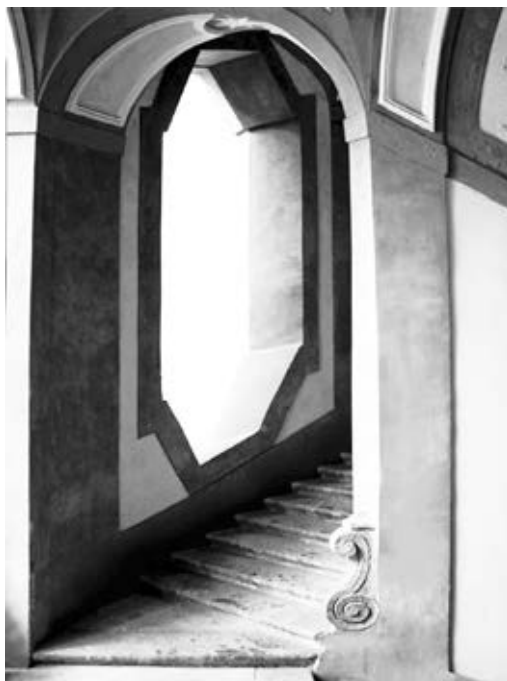
Figura 7. Napoli, Palazzo Capuano. Particolare delle finestre della scala (foto dell'autrice).
