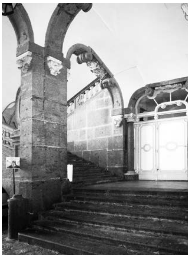
Figura 5. Napoli, Palazzo Serra di Cassano. Particolare della scala (foto dell'autrice).
