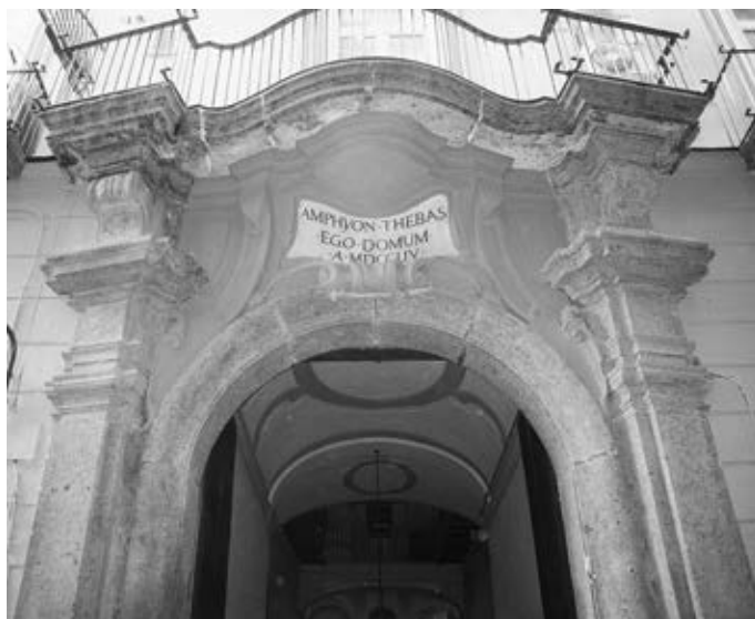
Figura 3. Palazzo Majorana. Particolare del portale (foto dell'autrice).
