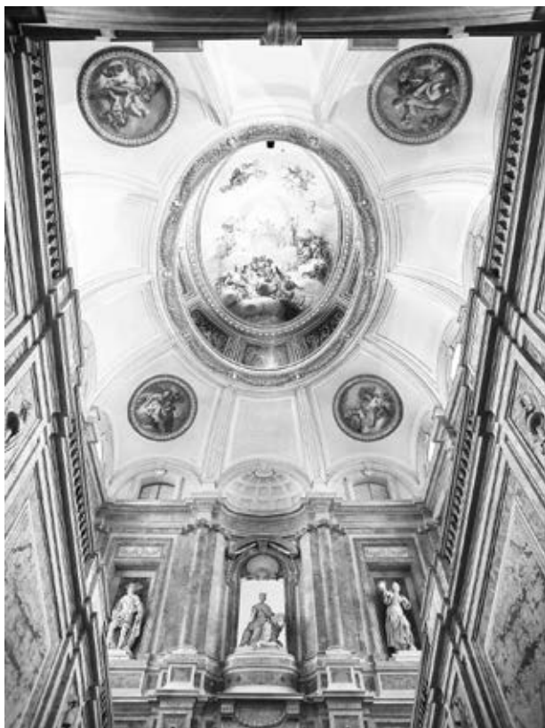
Figura 8. Luigi Vanvitelli, Caserta, scala del Palazzo Reale di Caserta, volta a doppia calotta (foto di Bruno Cristillo).
