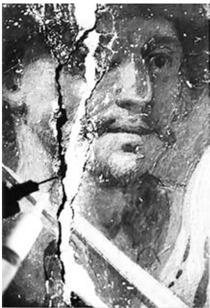
Figura 6. Injecció del morter hidràulic (fotografia de l'autora).
