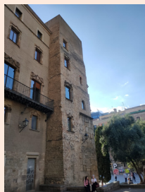
Torre de la Casa del Degà
