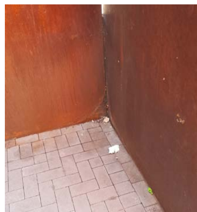
En esta imagen puede apreciarse el estado de abandono del interior de la escultura de Richard Serra. Terminal (1977/79)
