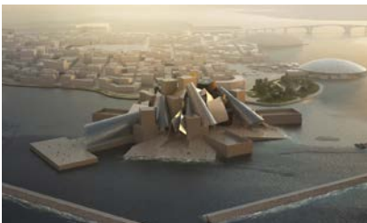
Guggenheim Abu Dhabi, en Emiratos Árabes Unidos, en fase de construcción
