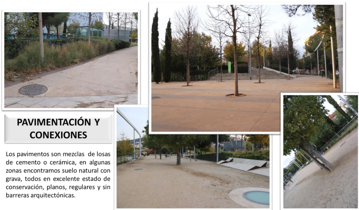
Figura 19. Pavimentación Parque de las Rieras de Horta Fuente: Elaborado por la autora (2021).
