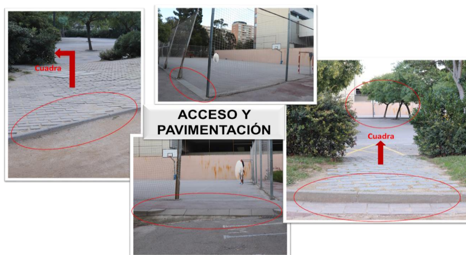
Figura 14. Acceso y pavimentación de la pista polideportiva - Jardines de la Maternidad
