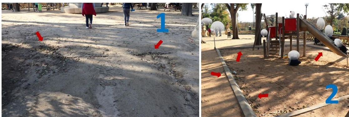
Figura 60. Acceso y pavimentación del área infantil 3 del Parque Ciutadella
