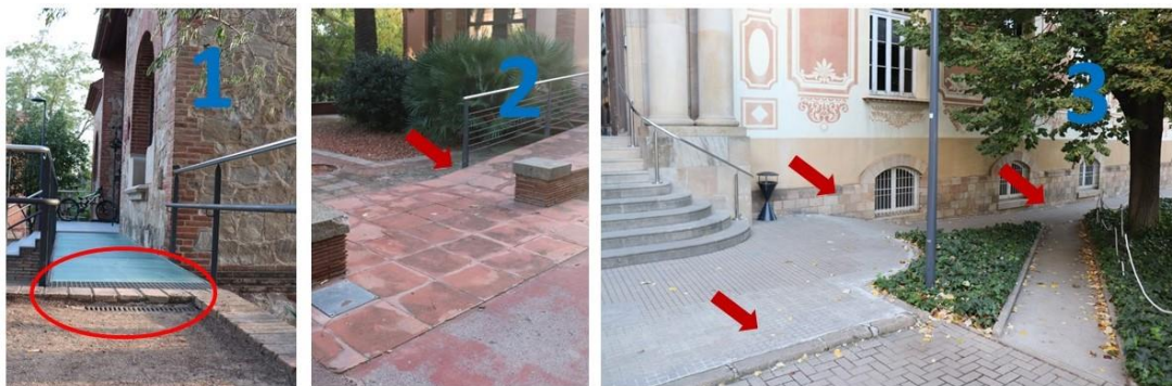
Figura 11. Rampas de acceso a edificios públicos en los Jardines de la Maternidad
