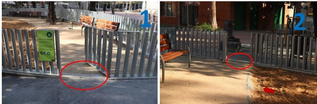
Figura 41. Acceso y pavimentación del área infantil - Jardines de Montserrat Fuente: Elaborado por la autora (2021).
