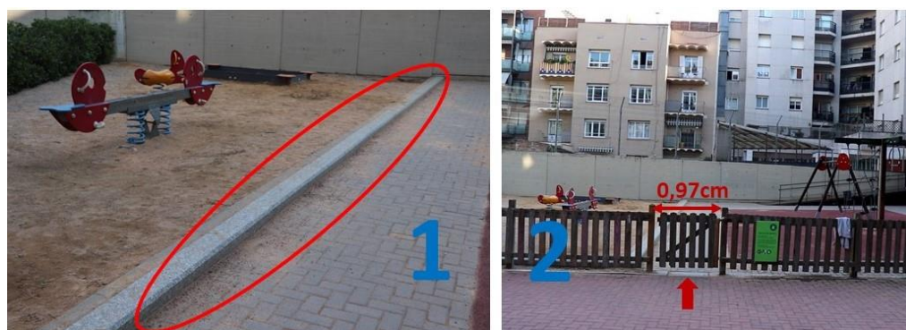
Figura 40. Acceso y pavimentación del área infantil - Jardines de Montserrat Roig
