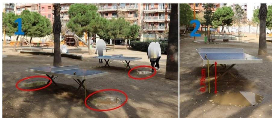
Figura 45. Mobiliarios/equipamientos y pavimentación del área deportiva - Jardines de la Industria Fuente: Elaborado por la autora (2021).
