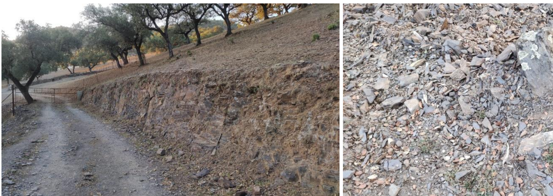
Imagen 11. Zona excavada en la misma finca para carril de tránsito de vehículos, donde se puede apreciar la geología del suelo con roca mayoritariamente del tipo pizarra
