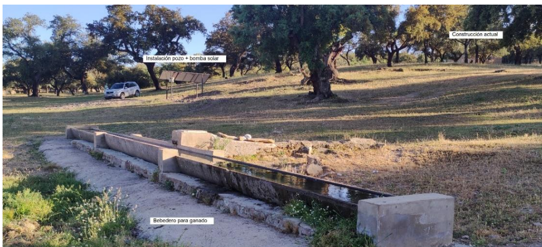
Imagen 8. Instalación de abastecimiento de agua de la finca
