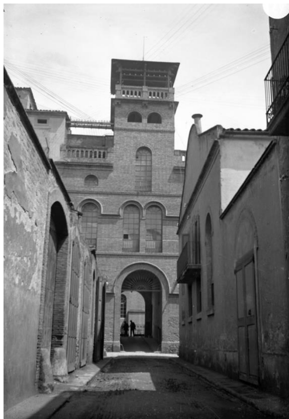
Figura 1. Fotografia de l'entrada principal de l'Anònima pel C/ de Llusa (1912 - 1926) Font: Fuerzas Hidroeléctricas del Segre, S.A., Arxiu Nacional de Catalunya
