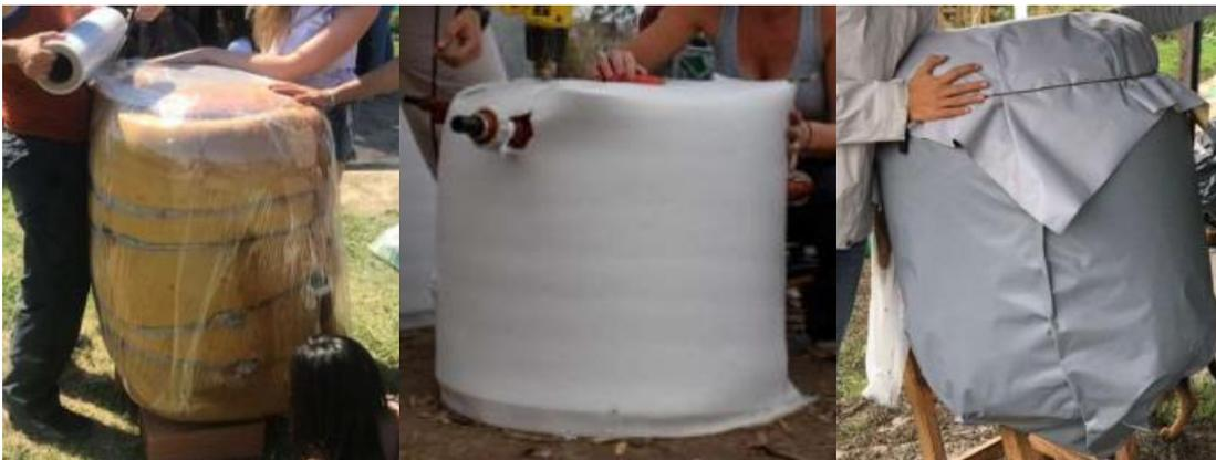
*Imagen. 30: Distintos aislamientos para el termotanque*
