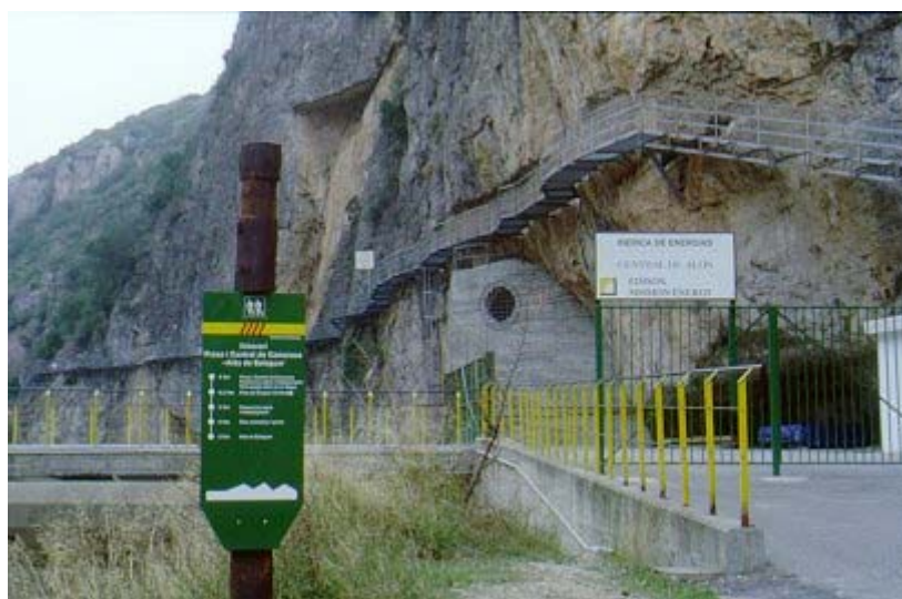
FIG. 11. Passarel·la metàl·lica a la presa de Camarasa.
