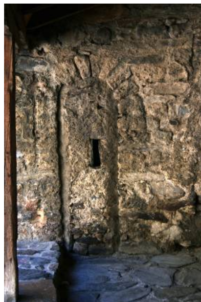
Figura 9. Antiga porta que d'accés al campanar des del porxo nord.
