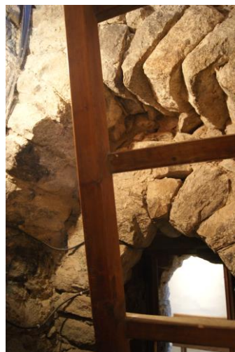
Figura 8. Detall constructiu de la porta a la base del campanar. Vista des de l'interior.
