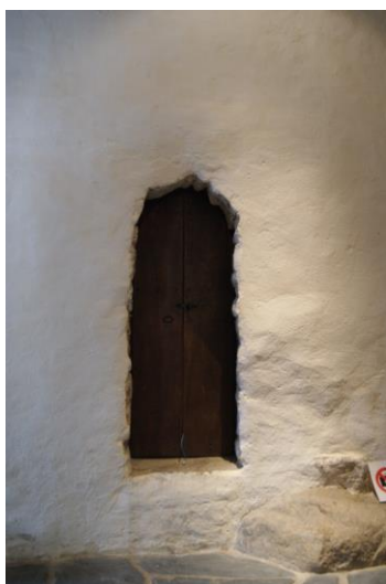
Figura 7. Porta oberta al mur nord des de la que s'accedeix a la base del campanar. Es veu també part del paviment actual de la nau i una gran pedra que serveix de fonamentació al mur.
