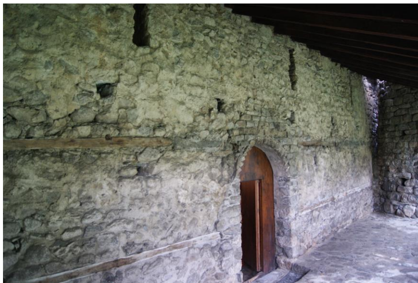
Figura 6. Porxo des del que s'accedeix a l'església. Sota coberta es veuen les finestres.
