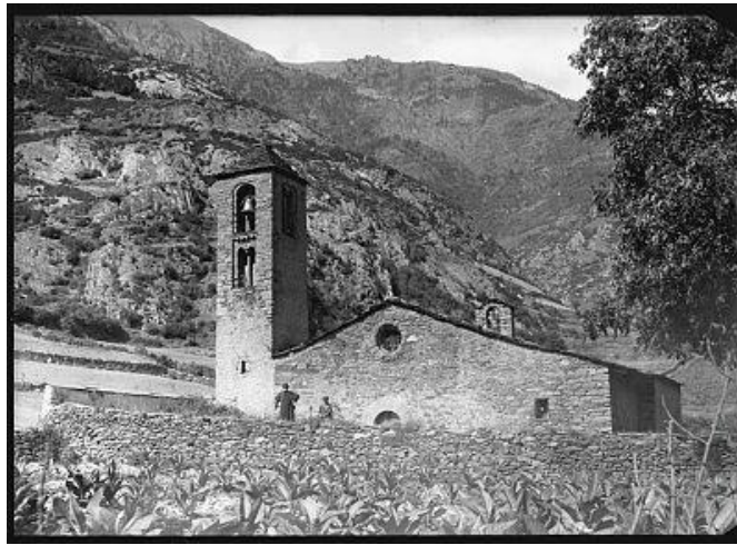
Figura 3. Sant Martí de la Cortinada abans de la restauració entre 1902-1920. Fons Guillem de Plandolit, 440. Arxiu Nacional d'Andorra.
