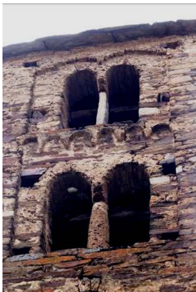
Figura 8. Finestres de la façana nord on s'aprecia el diferent tractament ornamental segons el pis.
