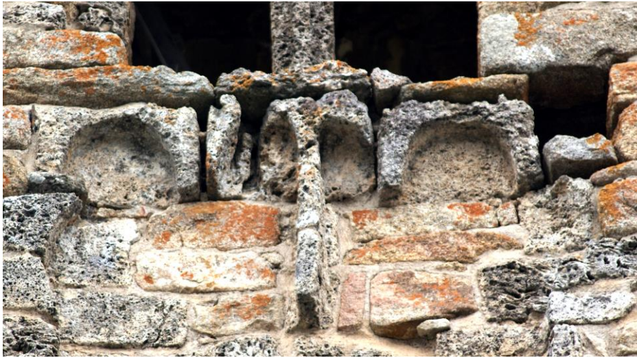
Figura 11. Detall constructiu en una de les finestres del campanar.
