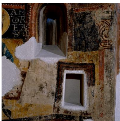
Figura 19. Armari que ocupa el tram final del cilindre de l'absis a la banda de l'epístola.
