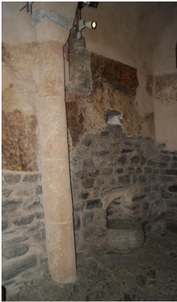
Figura 8. Una de les columnes adossades als murs de la nau, en aquest cas, al mur sud.
