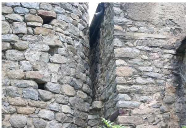
Figura 5. Connexió entre la nau i al campanar, amb restes del que sembla ser un antic muret.
