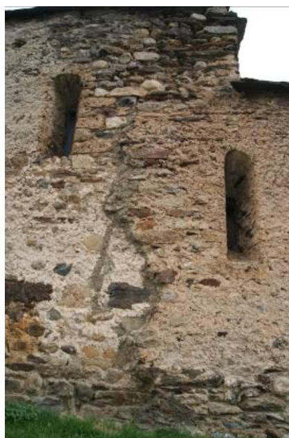
Figura 5. Entrega de l'absis amb el mur de la nau a la façana sud.
