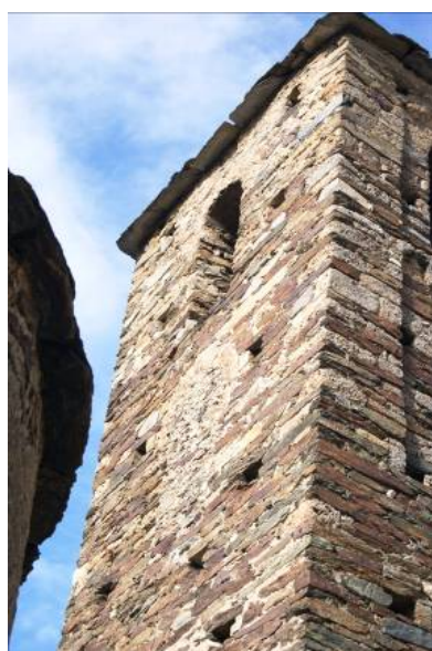
Figura 7. Façana sud del campanar.
