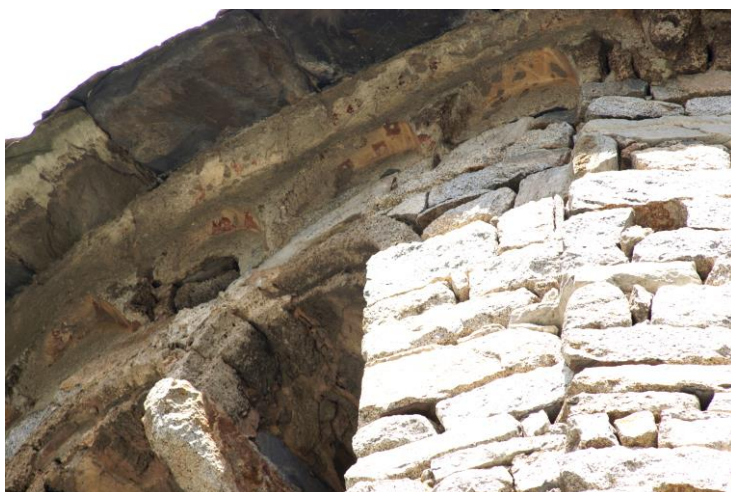
Figura 10. Fragments de pintura mural conservats a l'intradós de l'arcuació que corre sota la coberta del campanar.
