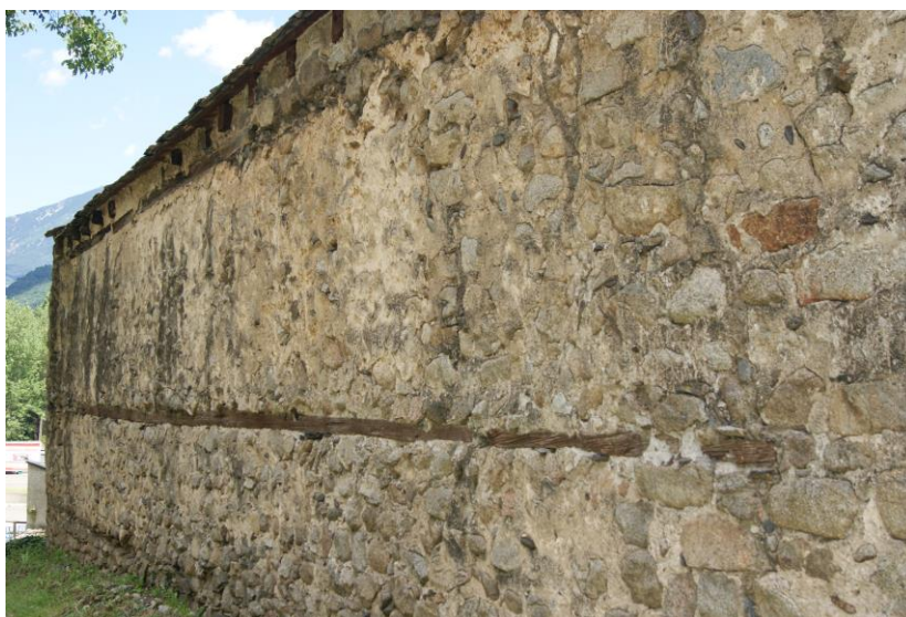
Figura 3. Detall de les bigues verdugades visibles a l'exterior del mur nord de la nau.
