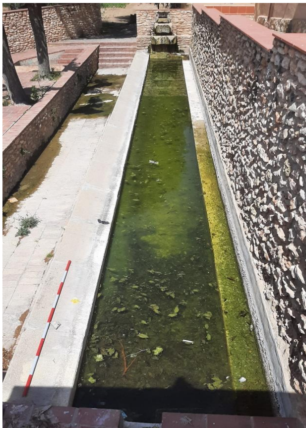
Fotografia n.6: Safareig de la Font de Santa Oliva. (Font pròpia)
