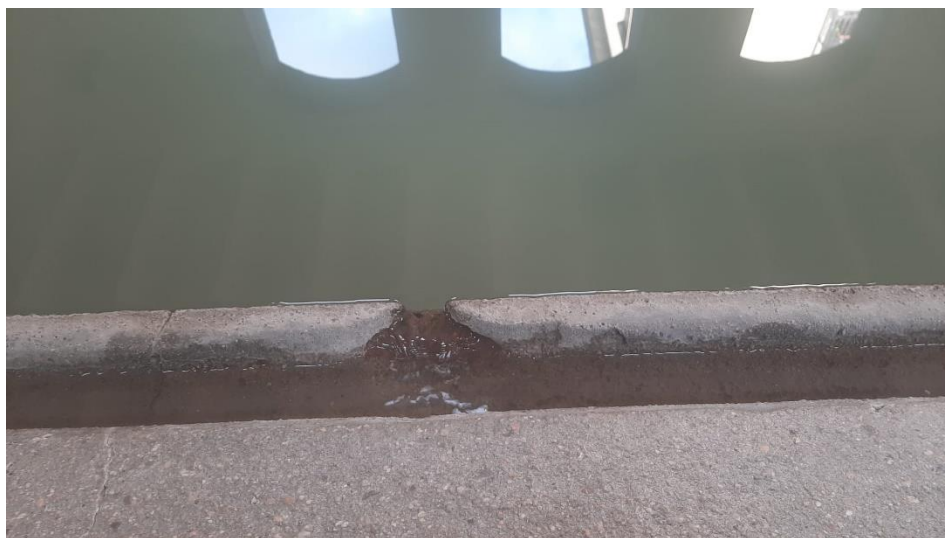
Imatge 55: Detall del regueró motllurat
