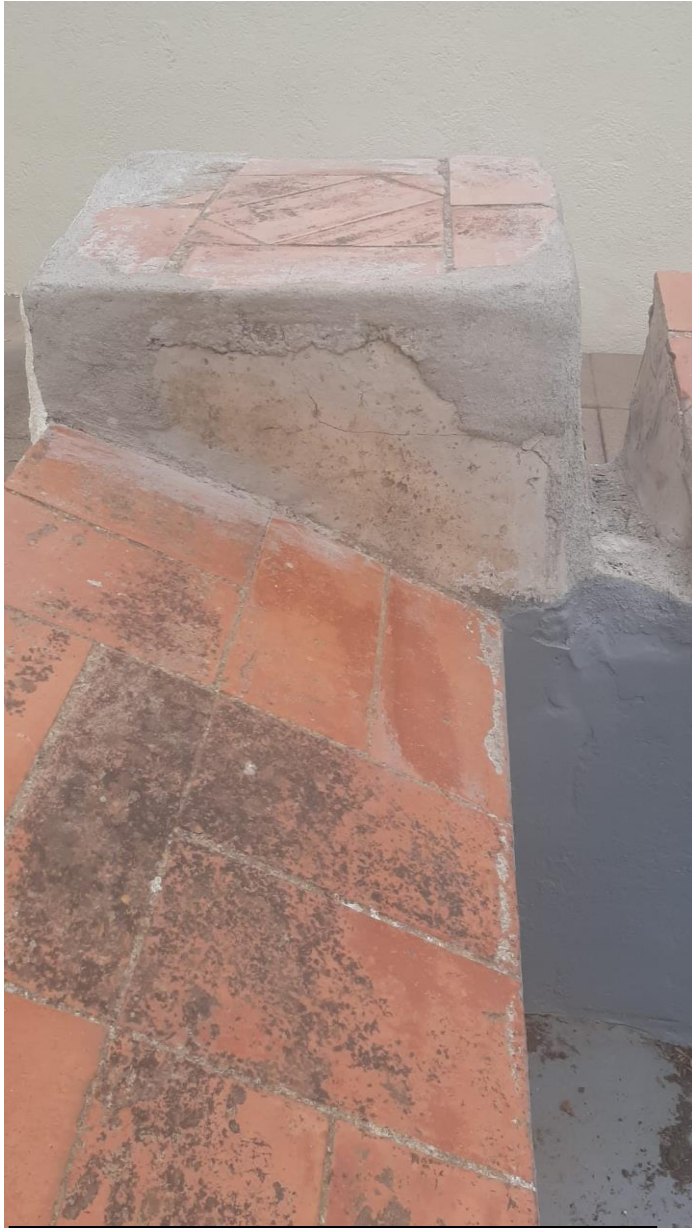
Imatge 84: Cantonada Sud-Oest des de l'interior
