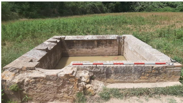
Fotografia n.10: Safareig de Xercavins (Font pròpia).
