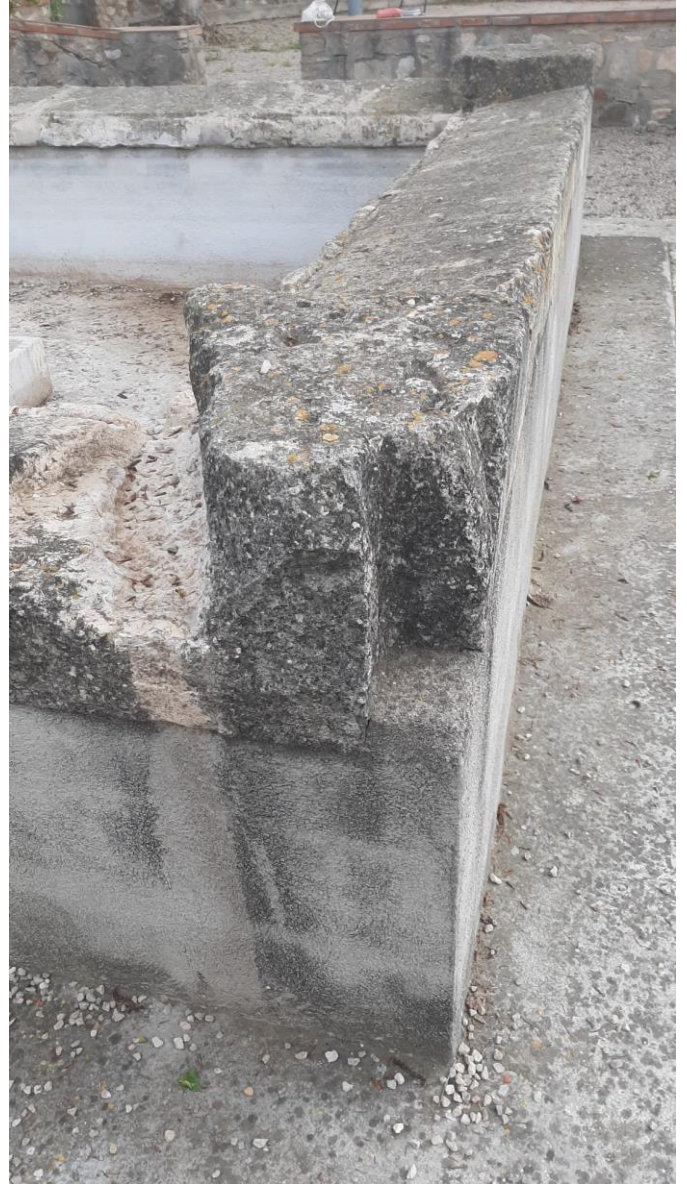
Imatge 76: Cantonada Nord-Oest
