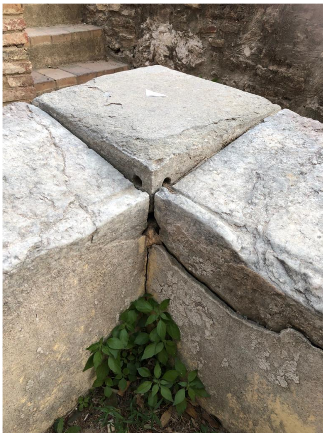
Imatge 15: Cantonada Sud-Est
