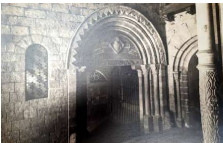
Fig. 43 Entrada de "El Refectorium". Fotografia Arxiu Mas
