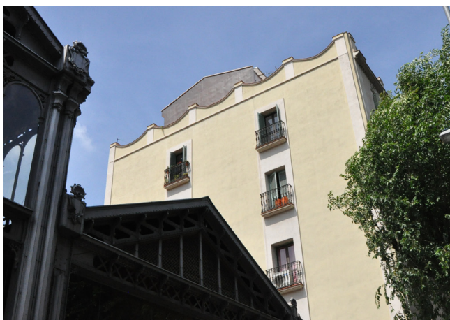
Figura 60: Fotografía de fachada medianera Carrer d' Aragó 313.
