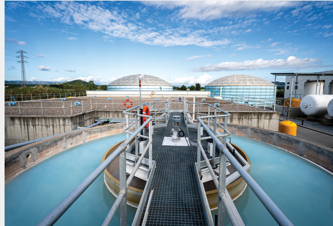
El Ministeri per a la Transició Ecològica finançarà íntegrament la construcció d'una nova planta dessalinitzadora al costat de la de La Tordera de Blanes (a la imatge) inaugurada l'any 2002. Foto de David Borrat /EFE.
