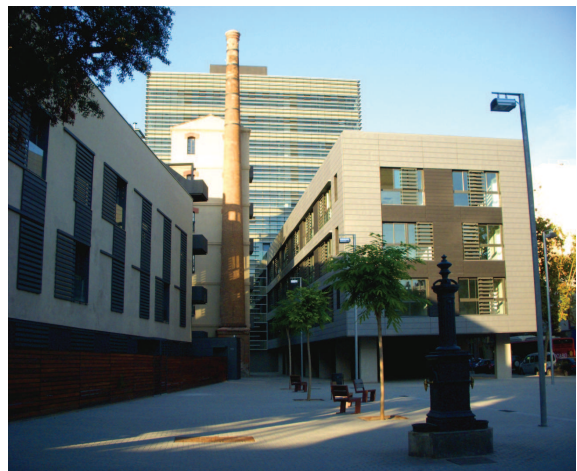
Fig.3.27- Distintas tipologias arquitetônicas e elementos urbanos de épocas diferentes criam um interessante espaço livre na esquina do quarteirão.
