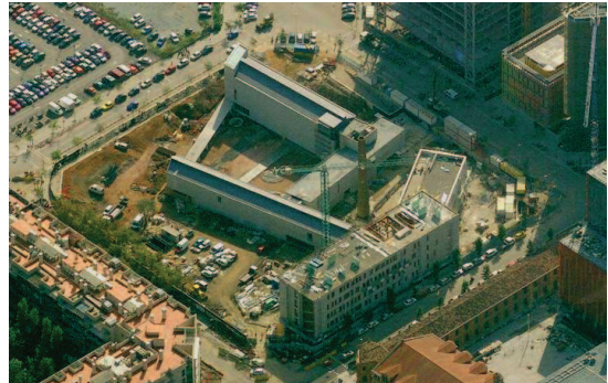
Fig.3.38- Vista oblíqua da antiga fábrica Can Framis.
