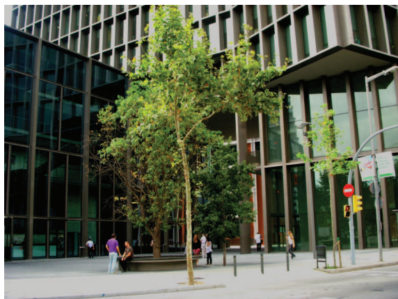
Fig.3.21- Espaço público na entrada do edifício MediaPro busca estimular a integração entre as diferentes dinâmicas empresarias ali presentes.
