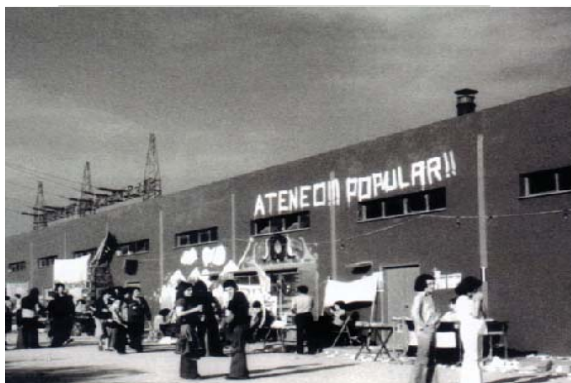
Fig. 12. La antigua fábrica de asfalto se reivindica como ateneu popular gracias a la movilización de los vecinos de Nou Barris, 1977.
