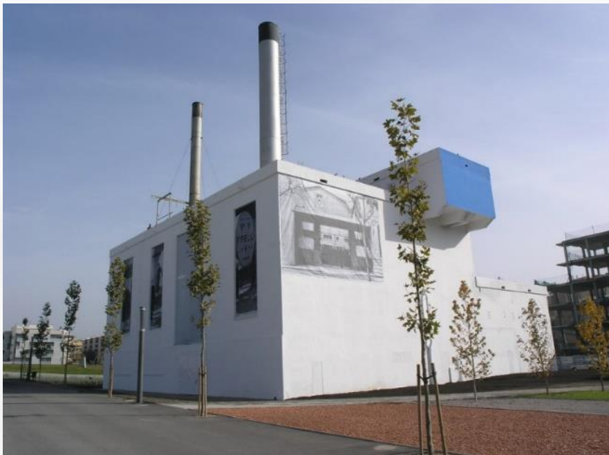
Figura 40. Nau de la fàbrica Pirelli, l'edifici de les Calderes. Font: Ajuntament de Vilanova.
