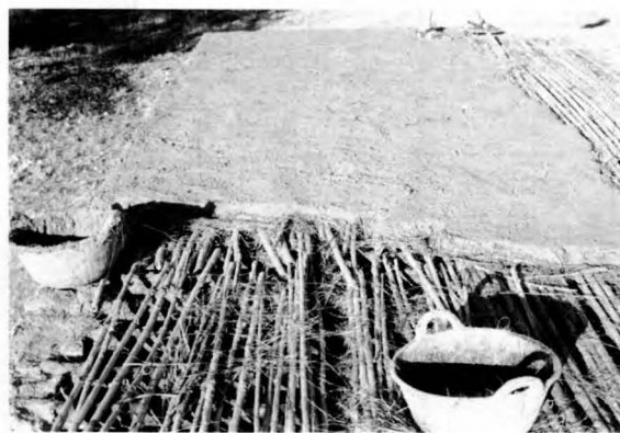
FIGURA 17: Procés d'elaboració de les cobertes (Laboratori d'Arqueologia Experimental del Vendrell).
