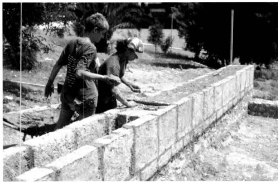
FIGURA 16: Col·locació del morter sobre una filada de toves (Laboratori d'Arqueologia Experimental del Vendrell).
