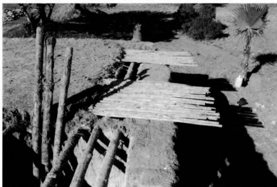
FIGURA 19: Construcció del voladís a la coberta per tal d'evitar que l'aigua de pluja afecti les parets de fang (Laboratori d'Arqueologia Experimental del Vendrell).
