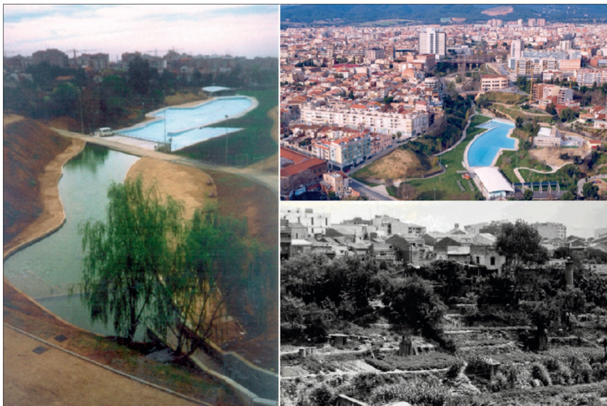
FIG. 4. Tres imágenes que reflejan la evolución y transformación urbana del torrente de Vallparadís. En la de la izquierda observamos el aspecto de la piscina-lago de Vallparadís una vez terminadas las obras de este sector (en los años noventa). En la imagen derecha superior, vista a vuelo de pájaro del parque de Vallparadís, en 1999, con la piscina-lago en primer lugar. En la imagen derecha inferior, Vallparadís en los años sesenta: huertas familiares y vegetación de ribera. Fuente: Imagen izquierda : Oliveres (2001). Imagen superior derecha : Archivo Municipal de Terrassa, autor desconocido. Imagen inferior derecha : Archivo Municipal de Terrassa, autoría de Jaume Amat.
