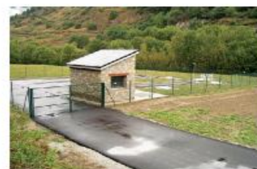
Depuradora d'Aubèrt (Vielha e Mijaran) Població servida: 650 habitants (h-e). Tractament biològic.
