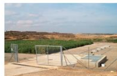
Depuradora d'Alfés Població servida: 325 habitants (h-e). Tractament de llacunatge.
