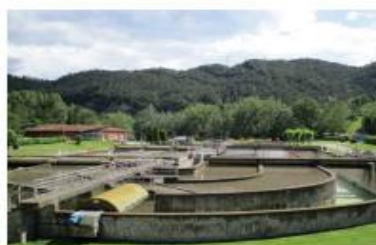
Depuradora de Ripoll Població servida: 45.000 habitants (h-e). Tractament biològic amb eliminació de nitrogen i fòsfor.
