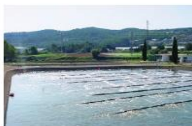
Depuradora de Bigues i Riells Població servida: 4.600 habitants (h-e). Tractament de llacunatge.
