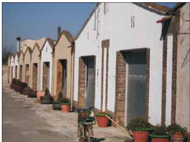
FIG. 3. Casas de la calle del Formigó. Primeras casas para trabajadores construidas en Raïmat en la década de 1920. El nombre de la calle ( hormigón en castellano) hace alusión al nuevo material empleado en su construcción.
