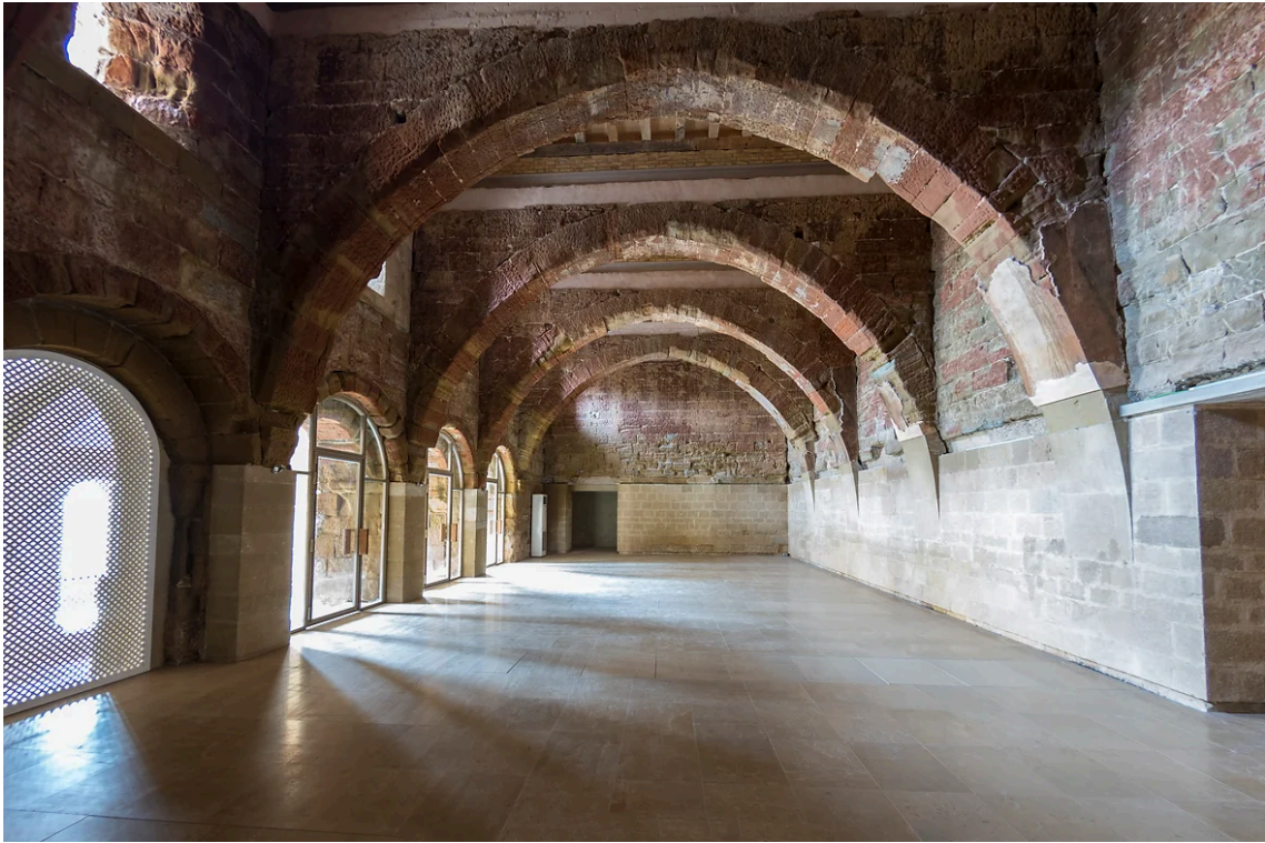
Fig. 9: Fotografia de l'aspecte actual de l'interior de la sala capitular del monestir, 2015 © Pemán y Franco Arquitectos
