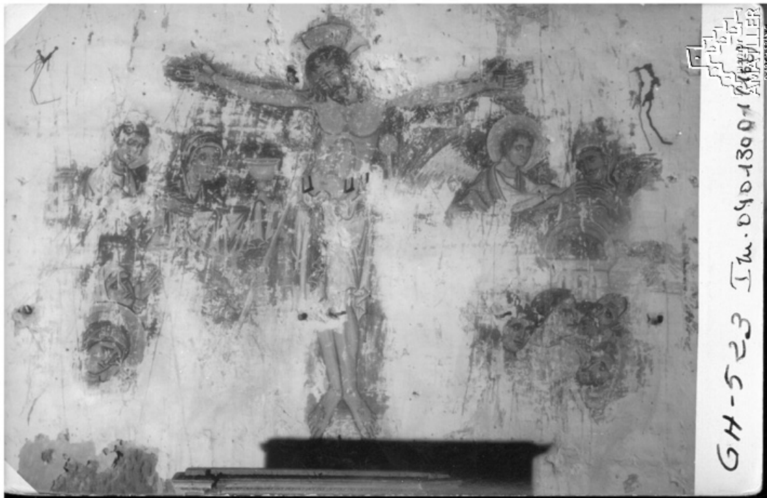
Fig. 35: Fotografia de l'aspecte de l'episodi de la Crucifixió després de l'arrencament de la capa de calç, 1936 © Arxiu Mas
