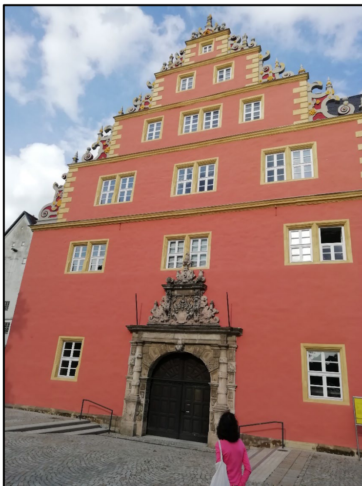
Edifici de l'Armeria
