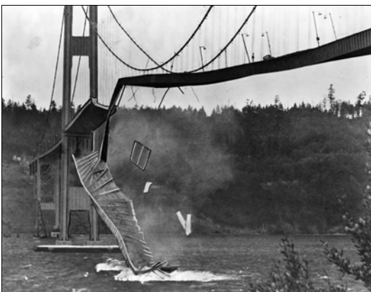
Col·lapse del pont de Tacoma Narrows, Washington, EUA Imatge de Library of the Congress ( https://www.loc.gov/ ) 1940
