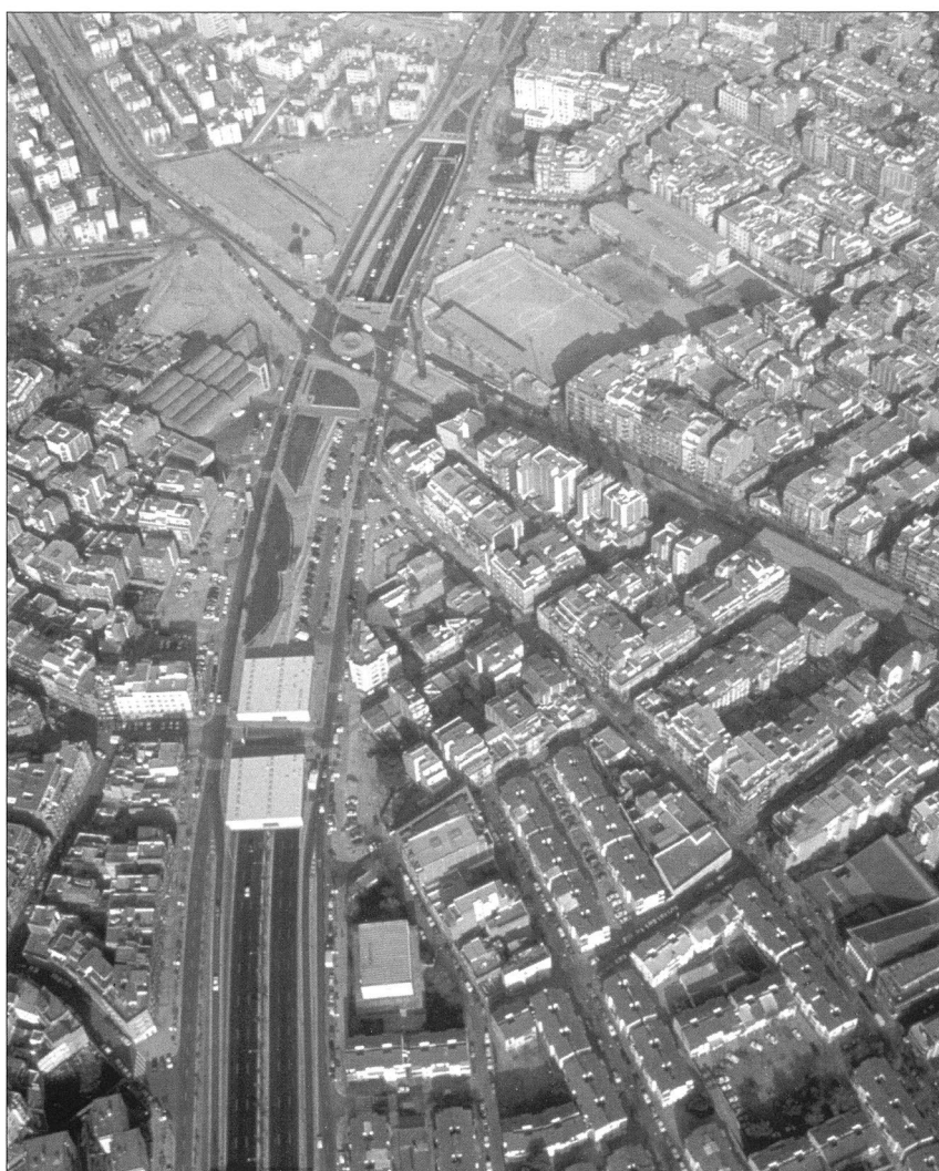
La ronda de Dalt, que forma part del nou cinturó de circumval·lació, en la travessia de Nou Barris (estiu de 1992).
