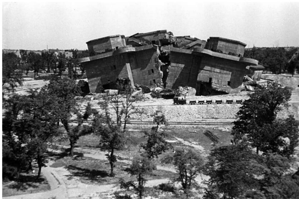
**Fig. 28** — Agosto de 1949. Vista de la *Flakturm II G* del Volkspark Friedrichshagen después del intento de voladura por parte del Ejército Rojo. En primer término se puede observar un *Trümmerbahn*, un tren ligero encargado de transportar escombros a través de los más de 300 kilómetros de vías que se instalaron en Berlín para facilitar el desescombro de la ciudad y que operaron hasta 1953. Fotografía de Otto Donath. Cortesía del Bundesarchiv · 183-M1203-316.
