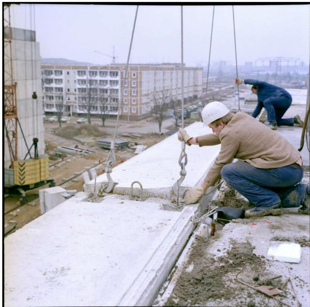
**Fig. 31** — 27/11/1986. Dos operarios del «Wohnungsbaukombinat Magdeburg» ensamblan elementos prefabricados en un nuevo edificio de seis plantas en la Kastanienallee del distrito berlinés de Hellersdorf. La «WBK Magdeburg» estaba conformada por los albañiles más jóvenes de todos los distritos de la RDA, y ayudaban a construir distritos de nueva planta en la capital. Fotografía de Peter Zimmermann. Cortesía del Bundesarchiv · 183-1986-1127-410.
