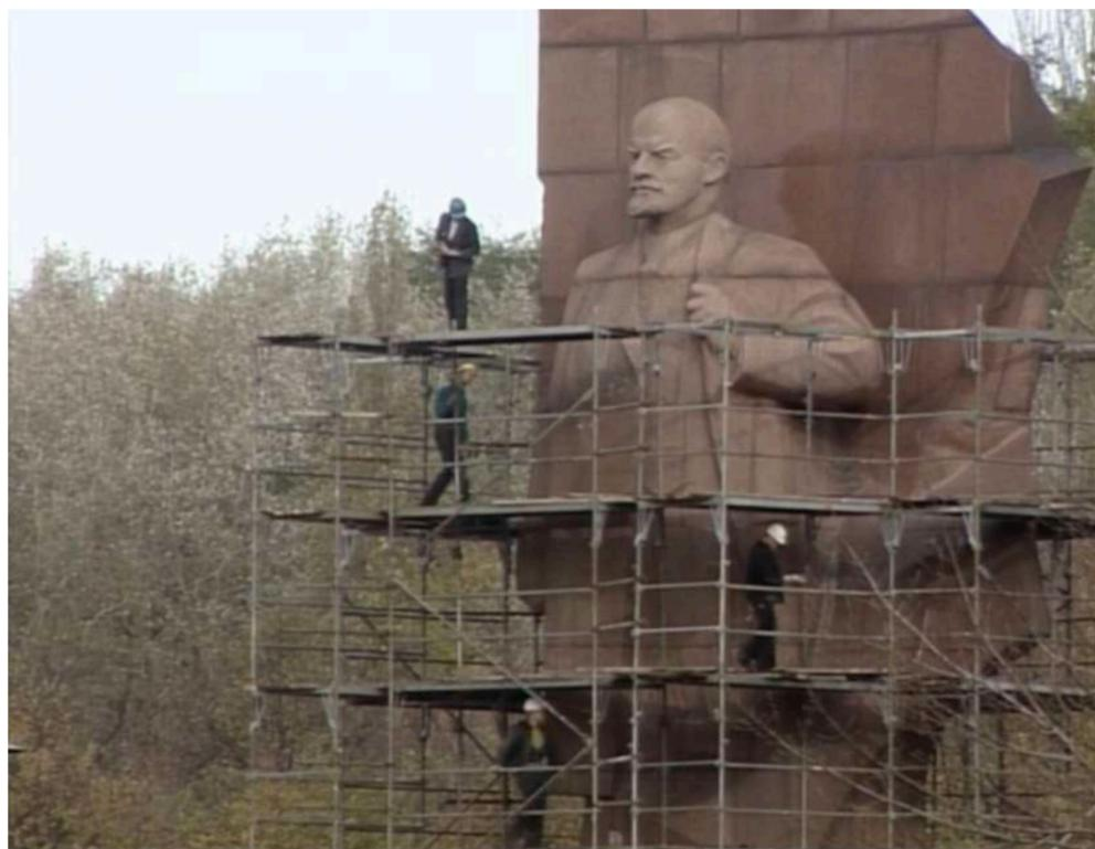
**Fig. 44** — 08/11/1991. Inicio del montaje del andamio con el que los operarios comenzarían el trabajo de desmantelado del *Lenindenkmal*. El fotograma ha sido extraído del trabajo de documentación que los periodistas Stefan Zimmer (cámara) y Matthias Matussek (locución) realizaron para DCTP TV.
