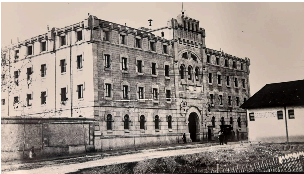
Fig. 41: façana al carrer Entença, 155. Extreta del COAC.
