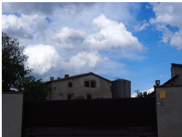
3.10. Vista de La Cavalleria des de l'exterior de la finca.
