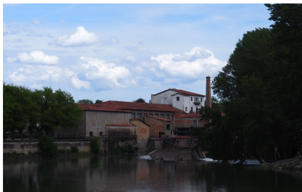
3.21. Vista general de les naus, la xemeneia i la resclosa de Can Llanas.
