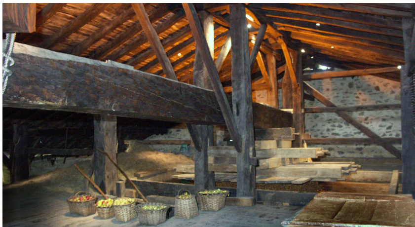
Figura 25. Interior del caseriu. Igartubeiti Baserria.
