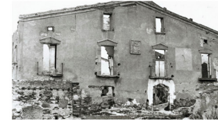
Vista de la façana en ruïnes, 1981. / Vista de la fachada en ruinas, 1981. Arxiu d'imatges del Museu de Badalona.
