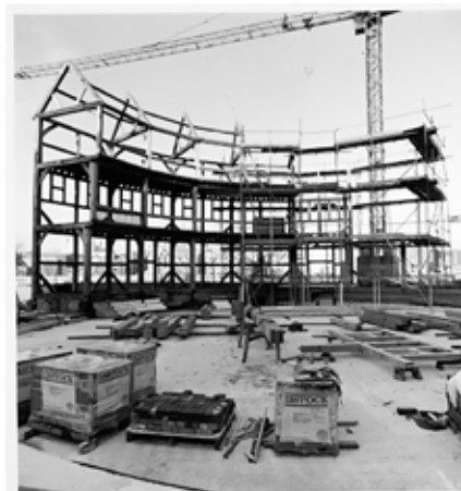
Fotografia històrica de la construcció del teatre Shakespeare's Globe Theatre. Font: Shakespeare's Globe Theatre and Archive
