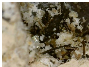
Fig. 96. Interior de la perforació on s'hi veuen les fibres de la fusta barrejades amb l'estuc. AV.IF-A.0011,24_AT_ML_perforacio_estuc_f.jpg
