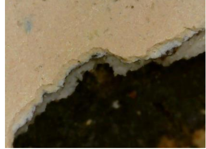
Fig. 92. Trencament amb els diferents estrats. AV.IF-A.0011,24_ AT_ML_trencament_f.jpg
