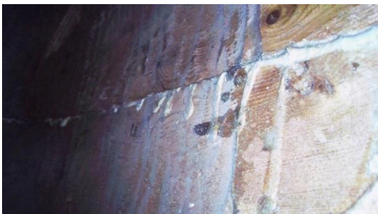
Fig. 97. Interior del bust, s'hi veuen les unions encolades i estucades.
