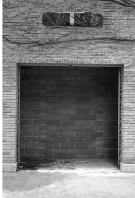
Figura 23. SIERRA, S. (2003). Muro cerrando un espacio / Palabra tapada . [Intervención en espacio arquitectónico]. https://www.santiago-sierra.com/200304_1024.php?key=1
