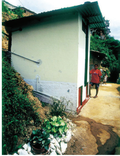
Figura 14. POTRC M. (2004). Dry Toilet . Caracas. [Instalación de inodoro comunitario]. http://www.potrc.org/project2.htm
