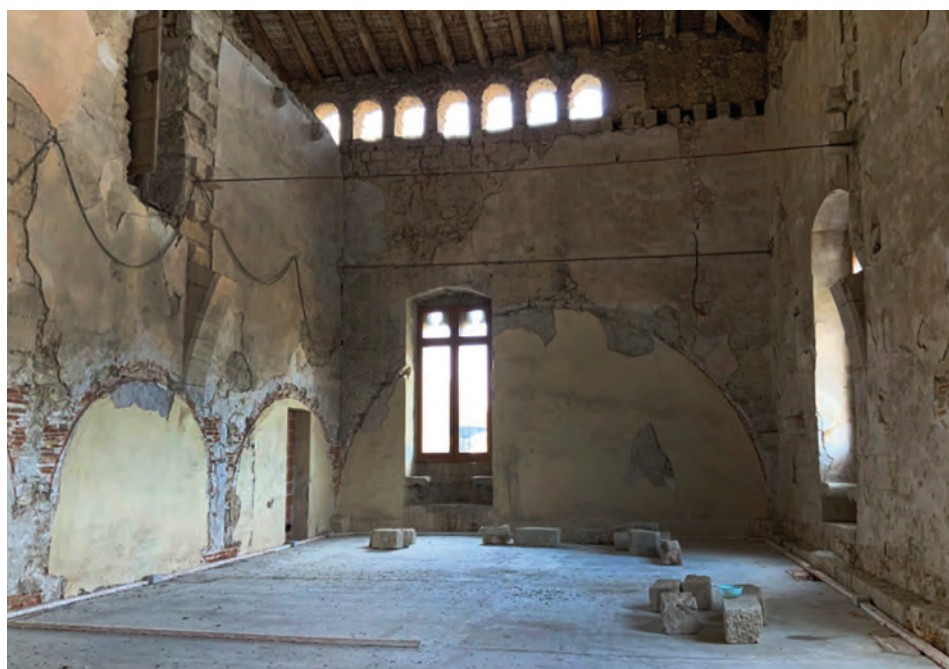
Fig. 4. Castell-palau de l'Espluga Calba. La Sala, a dalt, destruïda; a baix, en restauració (JFS, 1995; J.L. Cots, 2021).
