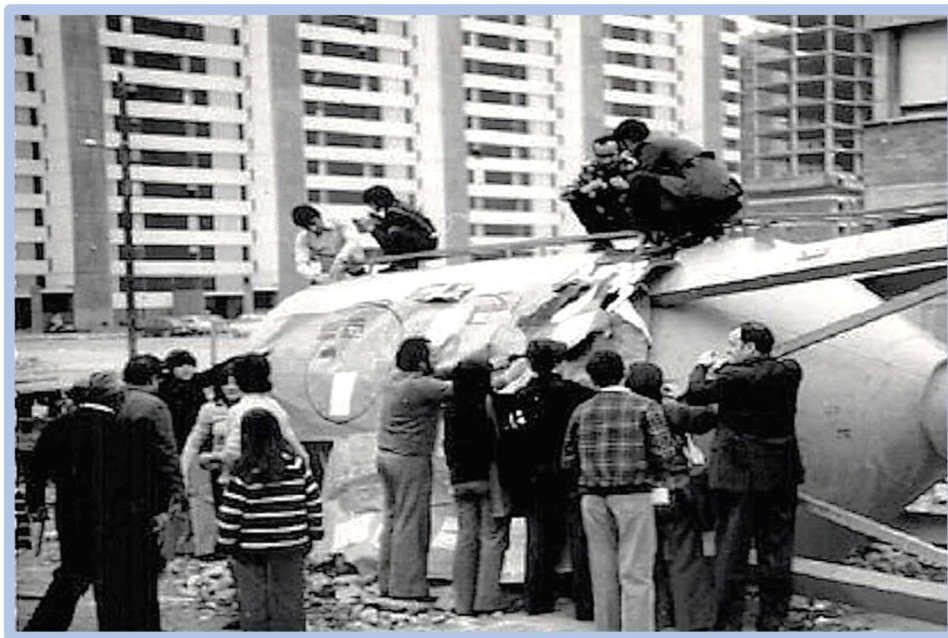
Intervención sobre el material; obra comunitaria.
