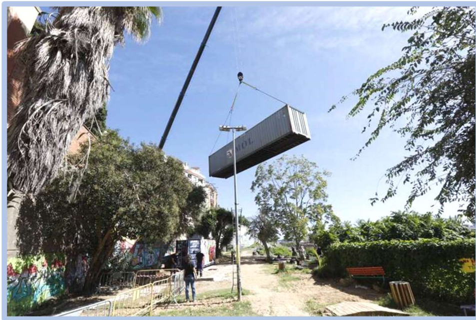
Transporte y ubicación del módulo en el Parque mientras se supervisa su colocación Fuente: Fotografía Europa Press
