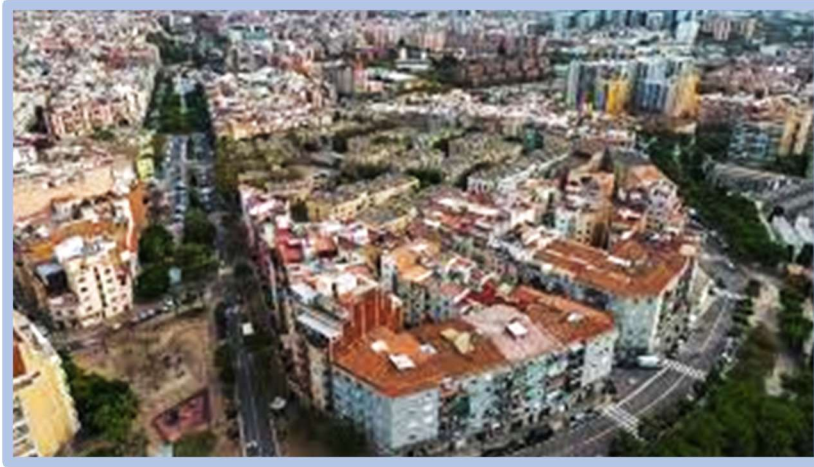
Imagen aérea del barrio de La Florida con Las Planas;
