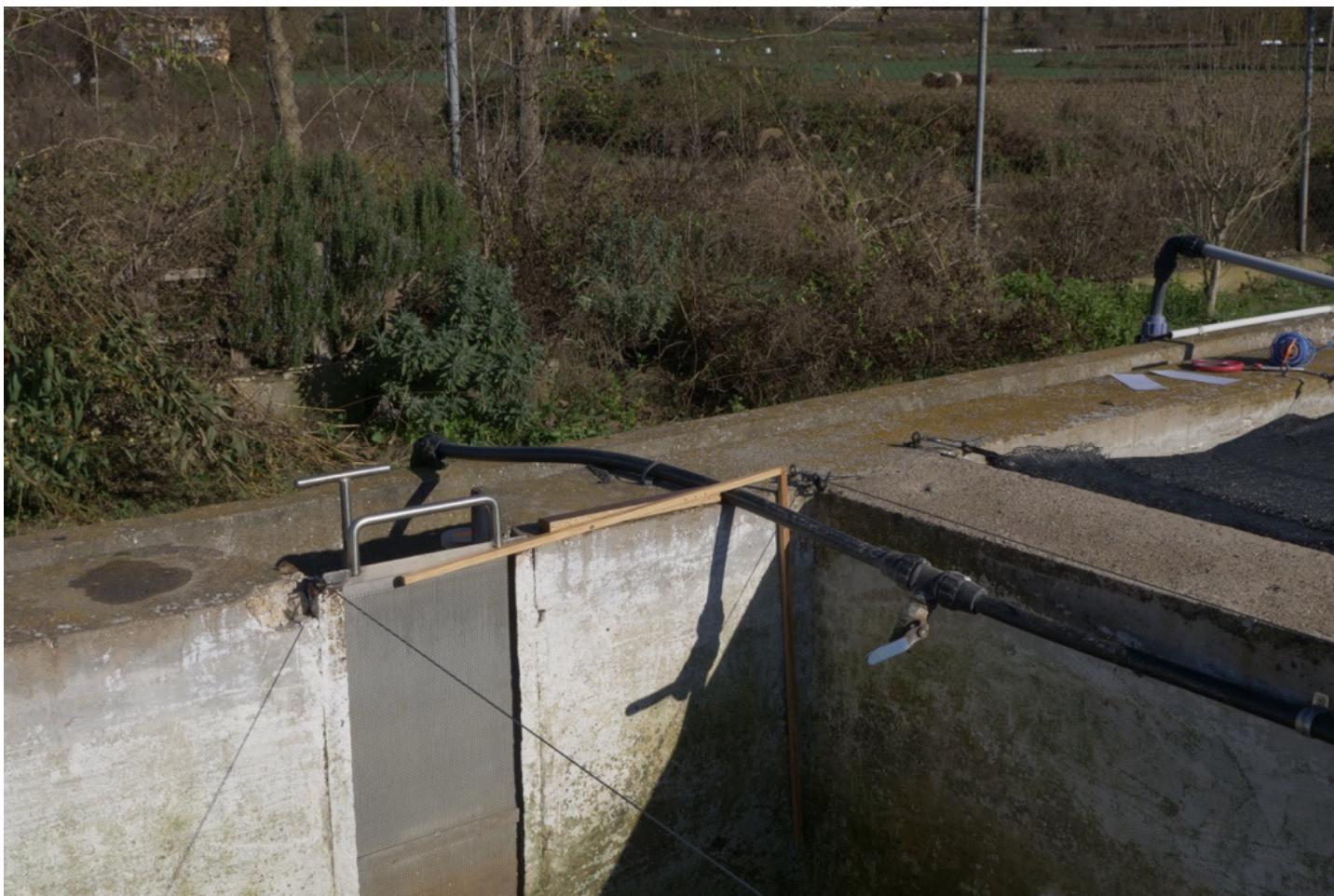
Figura 93. Angle recte de llistó de fusta i DM conglomerat per fixar el tub de recirculació de l'aigua de la piscina núm. 1. Intervenció site-specific al Molí de les Fonts. Sense evidència verbal , Job Ramos, (2021). [Fotografia]. Autor de la imatge: Job Ramos, 2021.
