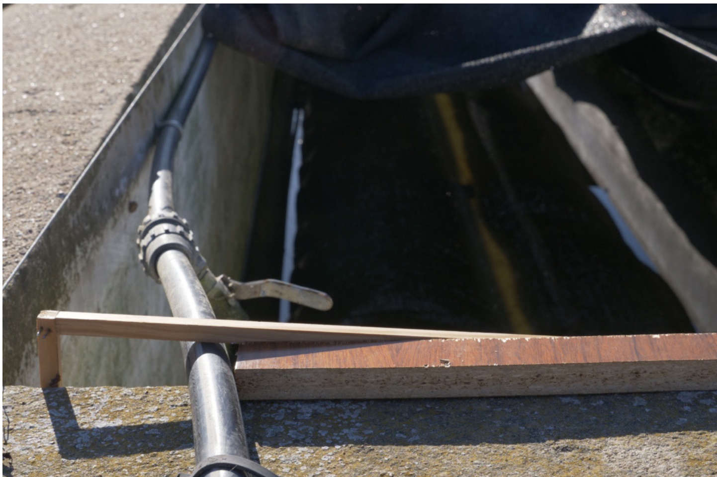
Figura 92. Angle recte de llistó de fusta i DM conglomerat per fixar el tub de recirculació de l'aigua de la piscina núm. 1. Intervenció site-specific al Molí de les Fonts. Sense evidència verbal , Job Ramos, (2021). [Fotografia]. Autor de la imatge: Job Ramos, 2021.
