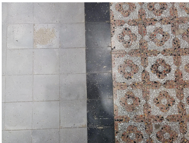
Fig. 44. Casa Sensat-Pagès, “Detall del paviment de la sala de la crugia nord de la planta baixa”. Fotografia de Nerea González Moreno. 10/05/2025.
