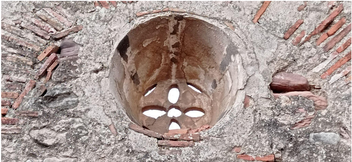
FIGURA 37. Rosetó amb restes de pintura des de la part interior de la façana.
