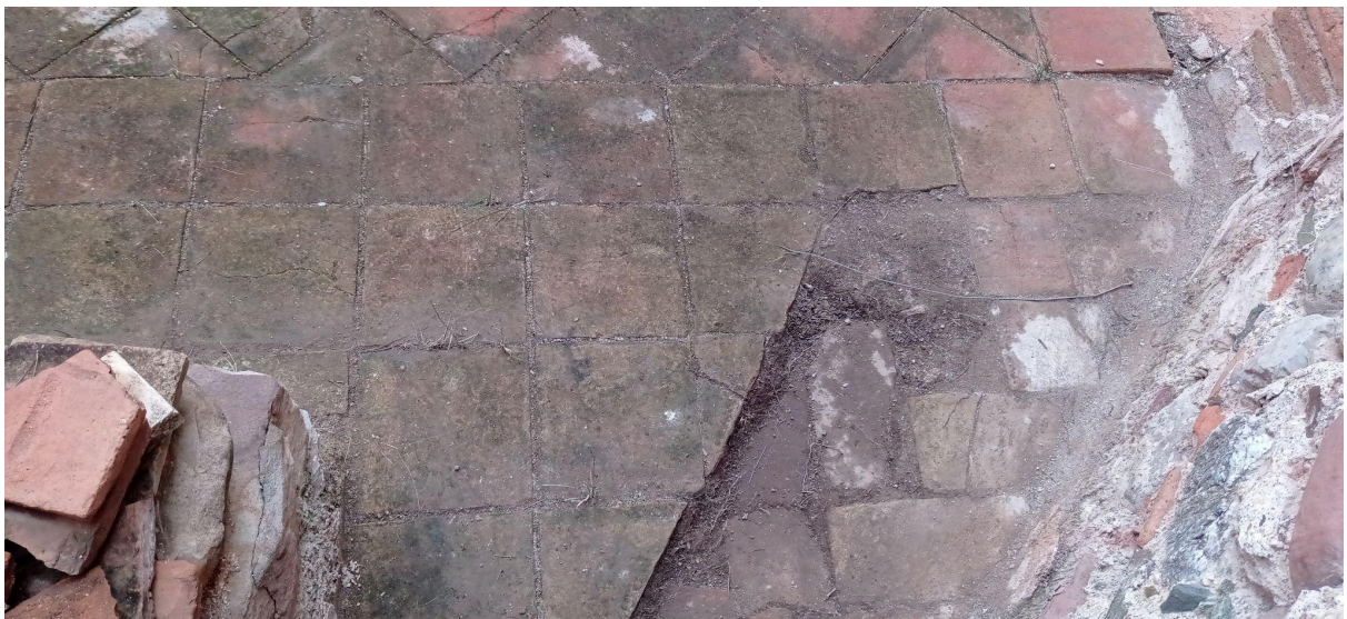
FIGURA 38. Restes del paviment més antic, rectangular i disposat en espiga, i a la seva esquerra les rajoles quadrades de la pavimentació del segle XVII.
