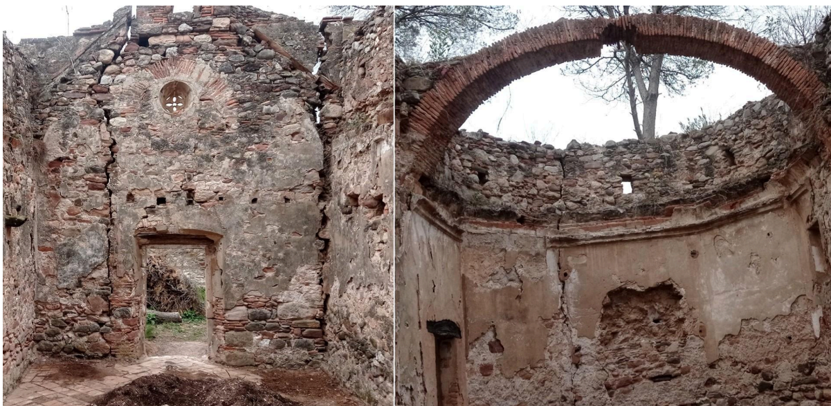
FIGURES 33 i 34. A l'esquerra façana vista des de l'interior, on es poden apreciar els forats on s'assentaven les bigues de la tribuna. A la dreta es pot veure el gran arc de totxana a punt de caure. (2023).
