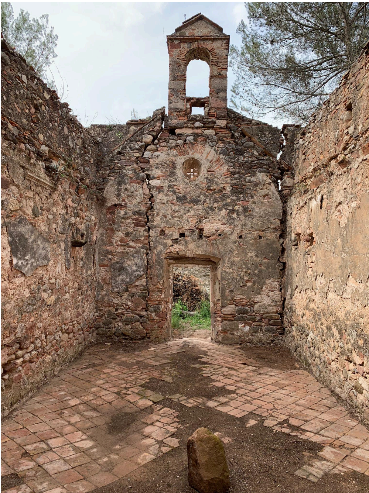
Façana orientada al sud, des de l'interior. 2024.
