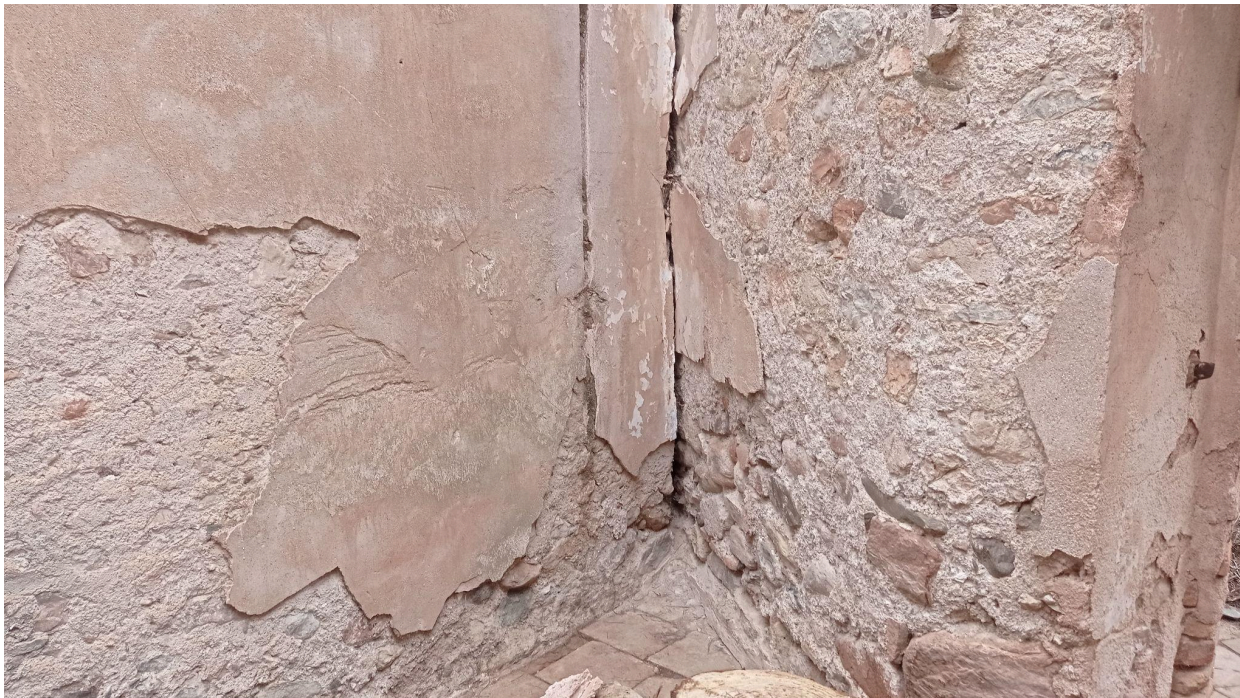
Interior de la sagristia. Es poden veure les restes de morter blanc i les marques del tub d'una possible estufa. 2024.
