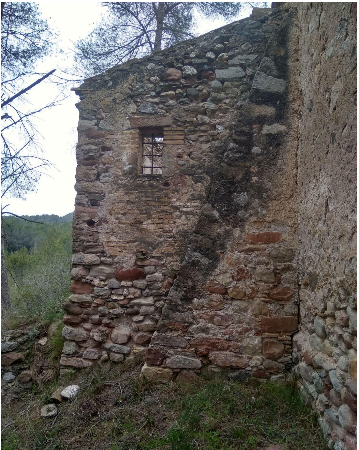
Contrafort i sagristia adossats a la façana oest. 2023.
