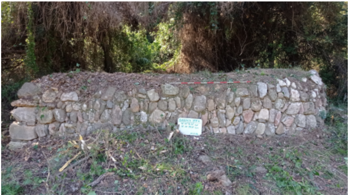
FIGURA 6. Restes d'una barraca del mas de Sant Jaume, de la qual només en queden els murs, ja que el sostre de fusta, característic de les barraques olesanes, fa temps que va caure (2020).
