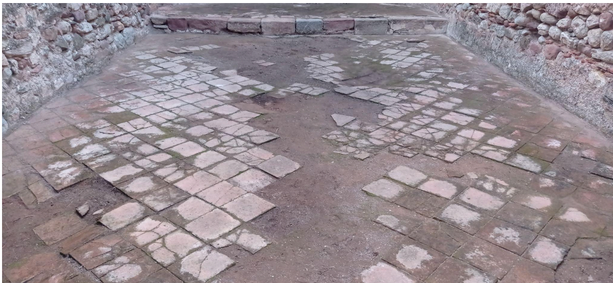
FIGURA 39. Paviment de rajoles de la nau principal del segle XVII (2023).
