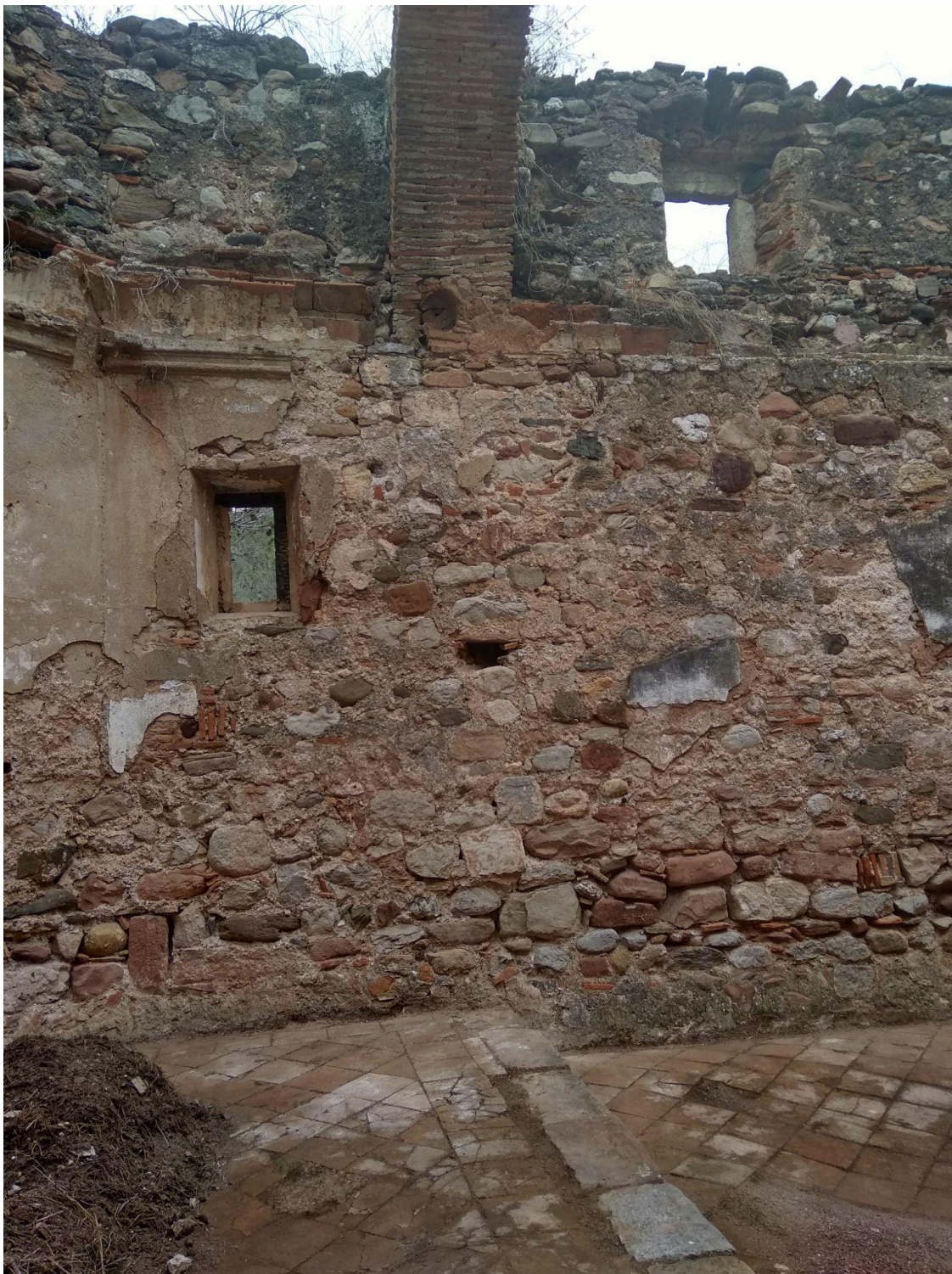
Visió des de l'interior del mur oriental, amb dues finestres. 2023.
