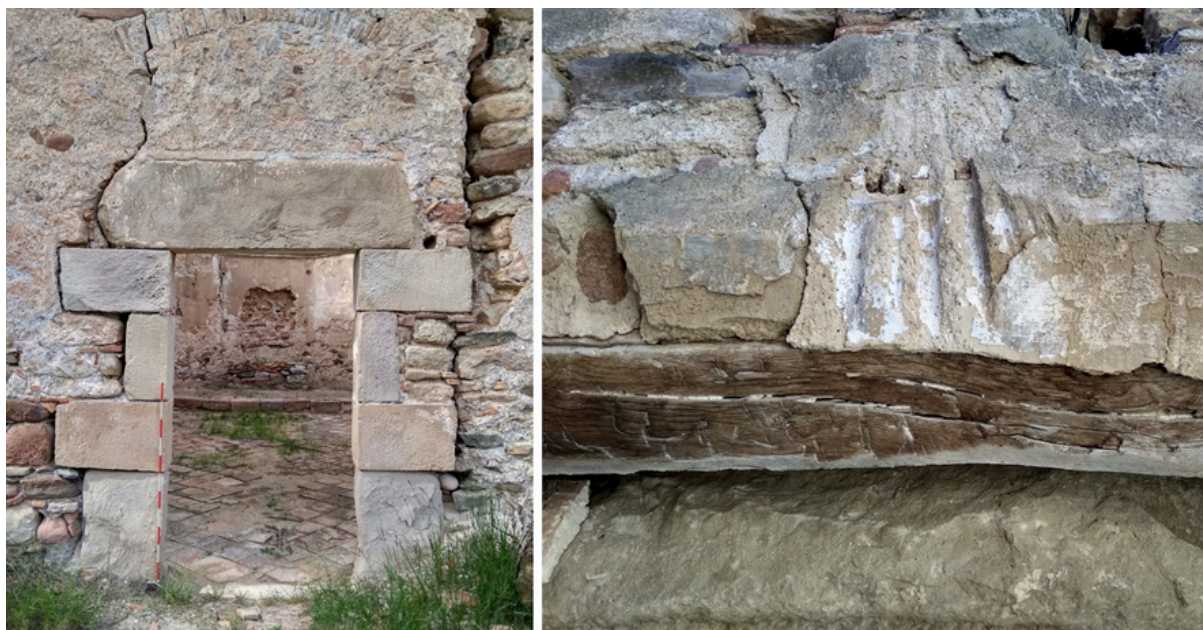
FIGURES 31 i 32. A l'esquerra, porta d'accés a la capella; es pot apreciar el gran carreu de la llinda. A la dreta, marques a l'interior de la porta, just sobre la llinda possiblement degut al fregament de la corda contra el mur en fer sonar la campana (2024).
