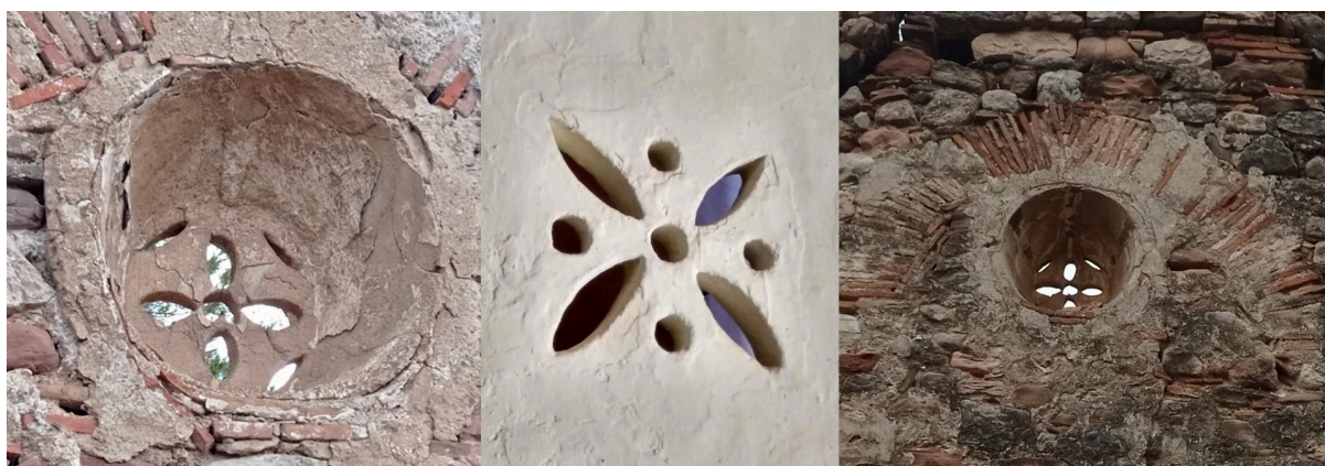
FIGURES 27, 28 i 29. A l'esquerra rosetó de la capella vist des de l'exterior. Al centre rosetó a l'escala d'accés a la sala del mas. A la dreta vista del rosetó de la capella des de l'interior on es pot apreciar l'arc de descàrrega. (2024).
