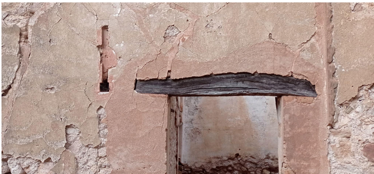
Exterior de la porta de la sagristia, amb el morter de color rosat. 2024.
