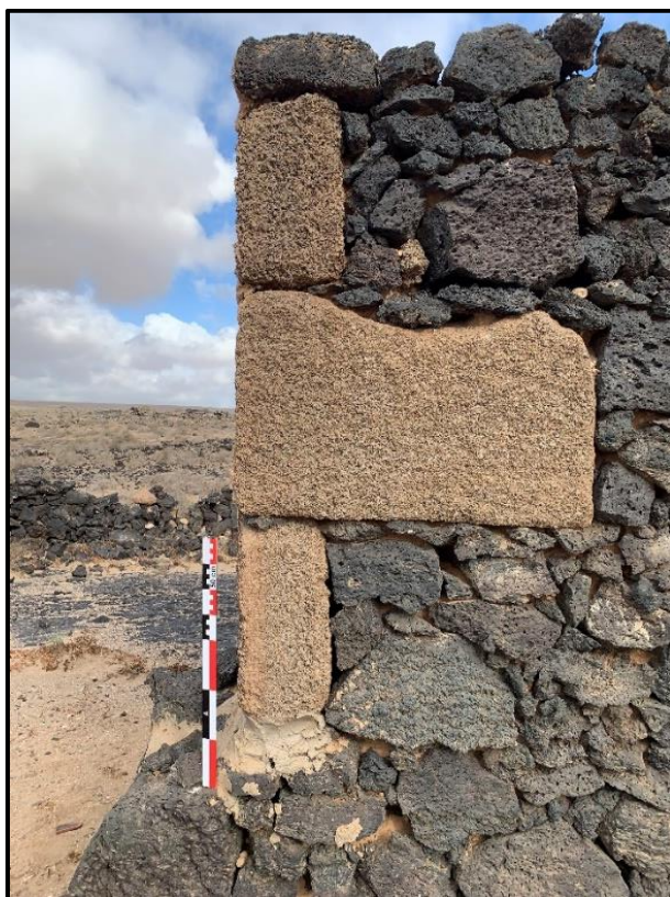
Figura 50. Fases constructives, cabana de la colada de las Nueces. Xavi Pradas, 2023
