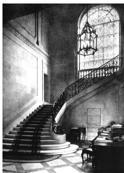
Fig. 12. Façana de l'Avinguda Montagne, 50. Fig. 13. La gran escalinata de l'entrada de l'Avinguda Montagne, 50.
