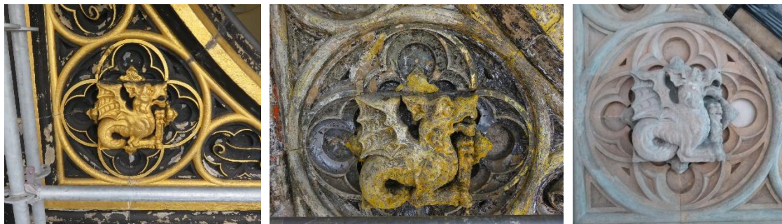
Imatges 5, 6 i 7. Procés d'eliminació dels estrats anteriors, fins arribar al substrat petri. A les imatges s'observa l'abans, el durant i el després del procés de decapat, en una de les ornamentacions de la torre Elisabeth. Fotografies de Cliveden Conservation (s. f.). Recuperades de https://clivedenconservation.com/project/elizabeth-tower/
