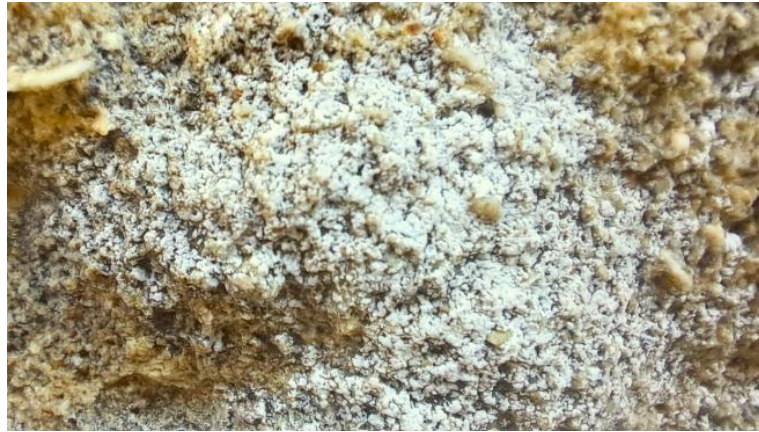
Figura 2. Fotografia de detall d'una eflorescència salina a l'interior d'un alvèol.
