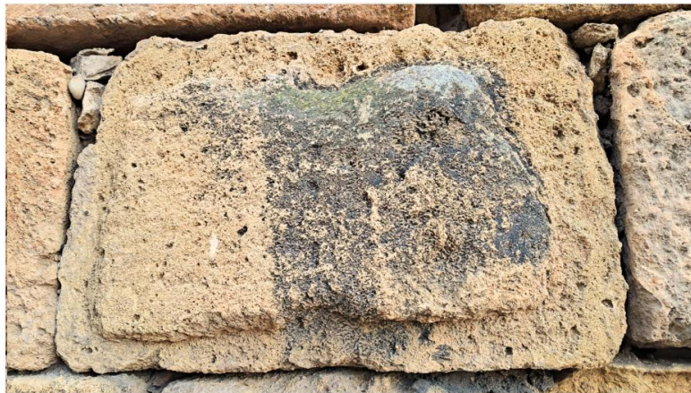
Figura 6. Fotografia on destaca la presència de colonització biològica, responsable d'una alteració cromàtica fosca i verdosa.
