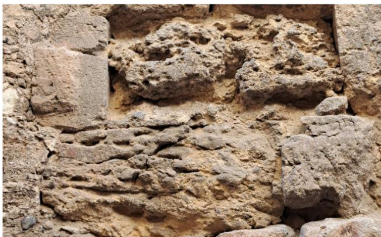
Figura 4. Fotografia on es destaca, per una banda, la reducció de massa de dos carreus respecte als del voltant, i per l'altra, l'elevada presència d'alvèols.
