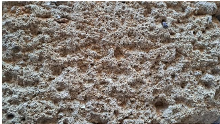
Figura 3. Fotografia d'un carreu on ressalta la rugositat superficial (piconat).
