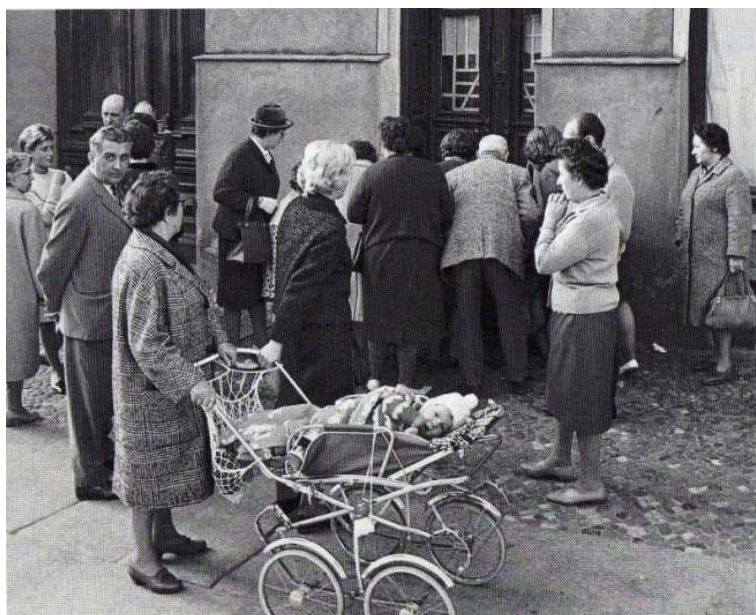
Fig. 24. Sòtan de la casa al barri de Wedding on acabava el "túnel 57" 179 .
