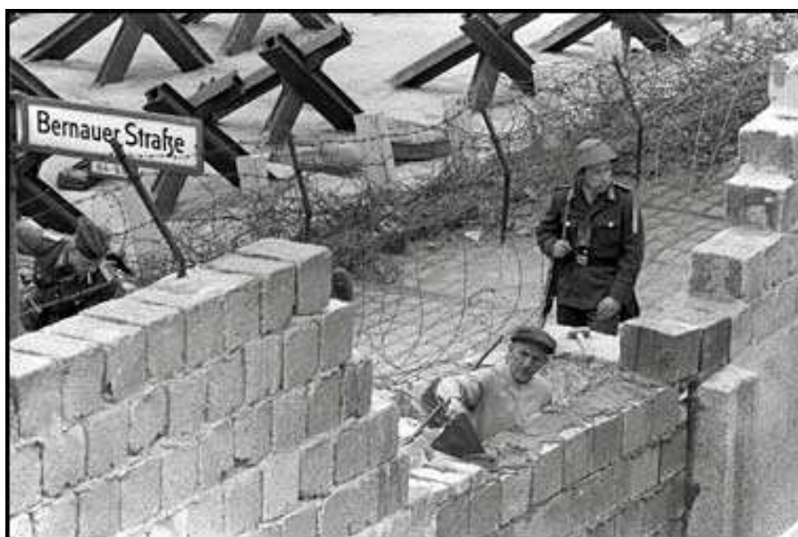
Fig. 14. Construcció del mur, el 26 de maig de 1962. El paleta està arreglant els desperfectes causats per una explosió contra el mur 145 .
