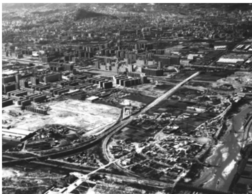
Explanació dels terrenys per a la construcció del barri
