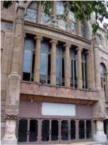
Façana, abans de les obres.
