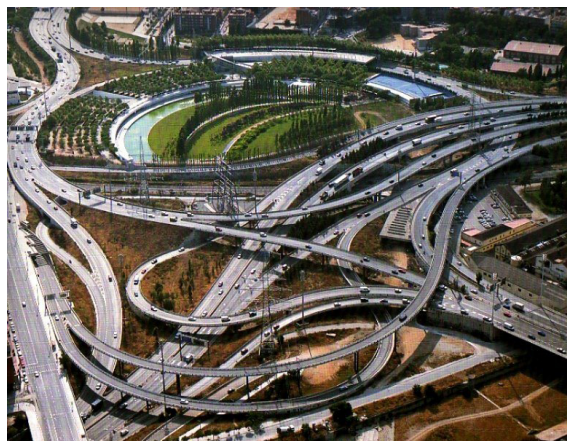
Figura 1.5: Nudo de la Trinidad. En él confluyen diversas vías como la Ronda Litoral, la Ronda de Dalt, Autopista C-58 Sabadell-Terrasa-Manresa, Autopista C-33 Girona-Francia o la Autopista hacia el Maresme. Pero además se ha aprovechado para construir un espacio urbano de gran calidad, el Parque de la Trinidad, en medio de este nudo de autopistas y ferrocarriles.
