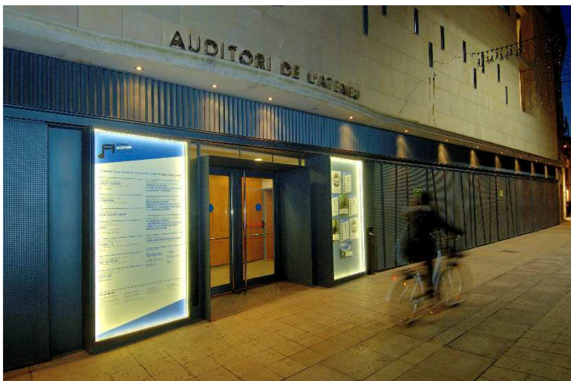
Exteriors Auditori de l'Ateneu – CMEM, Carrer Canal. Fotografia J. Curto.
