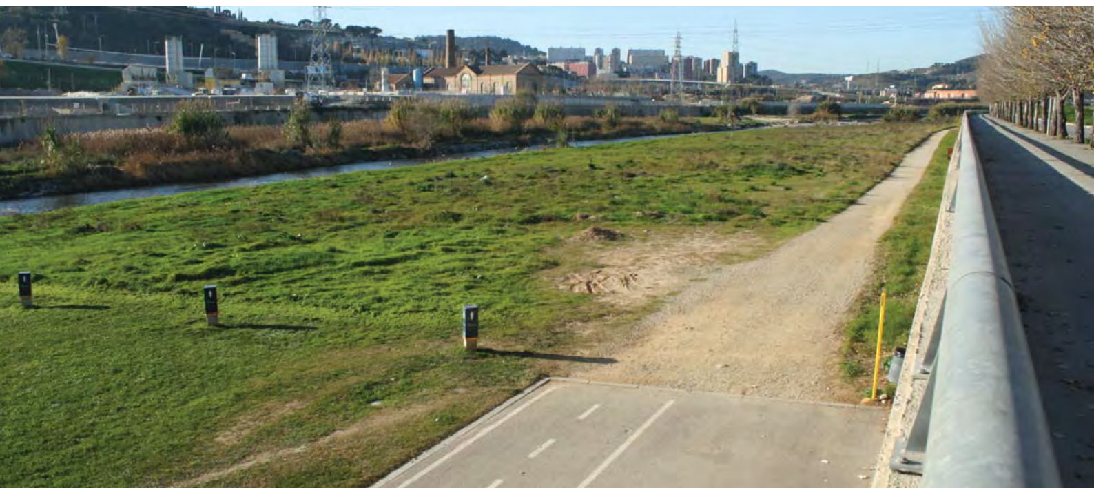
fig. 3.21 Transición entre las zonas de uso públicas y zonas húmedas del Parque fluvial del Besòs
